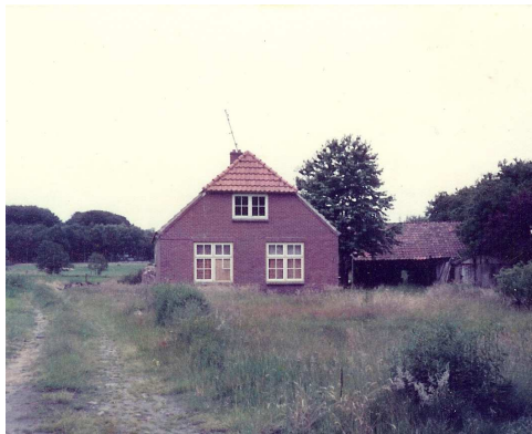
Koldenberg na verplaatsing en voor de renovatie
