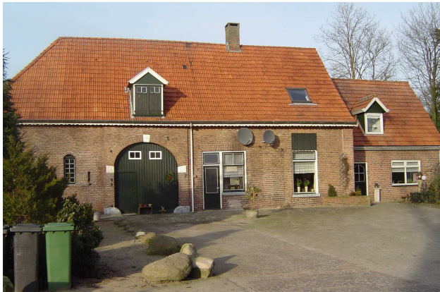
Boerderij Stoevelaar; op de plek van de aanbouw rechts was vroeger de ronde herenkamer.
