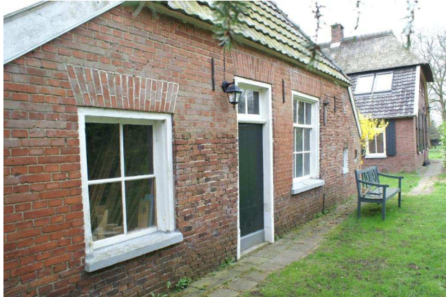
Het tot schuur gedegreerde oude huis van de ter Welle's
