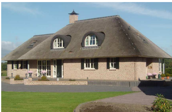
Het in 2006 nieuw gebouwde landhuis op OostJan
