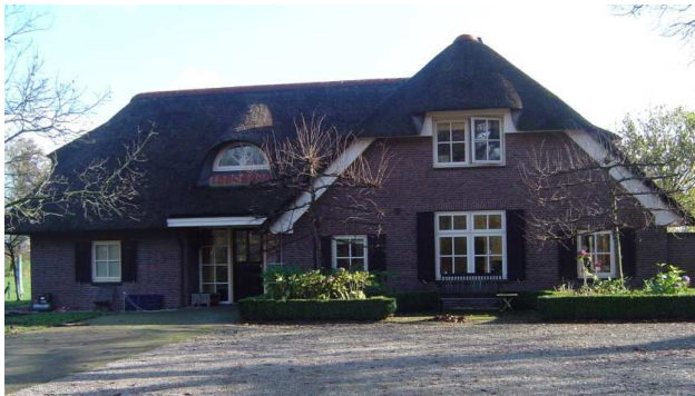
Het in 1997 op TönsJan gebouwde landhuis
