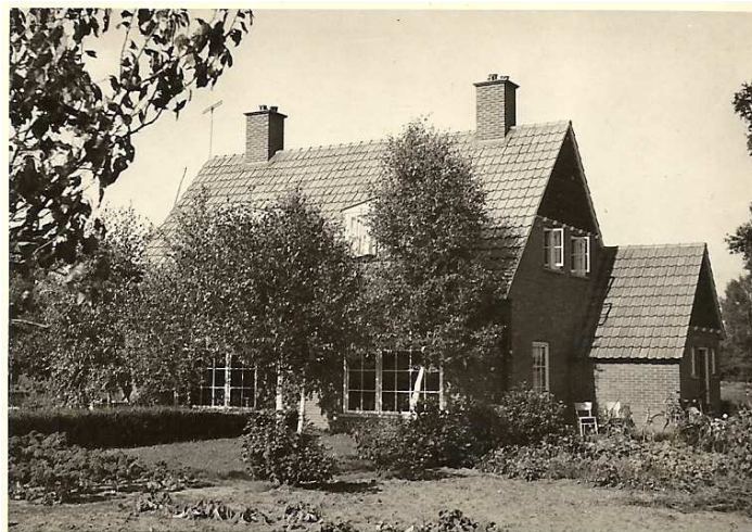
Achterzijde voormalige dubbele woning Kemperweg 5/3
