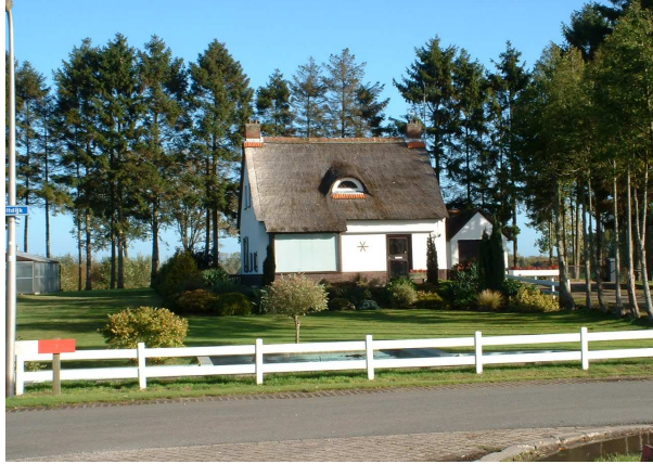
De afgebroken woning
