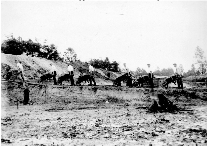
Kanalisisatie van de Schipbeek in 1930.
