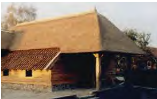
Wegzijde nieuwe schuur Scholendijk 4, Elsen
