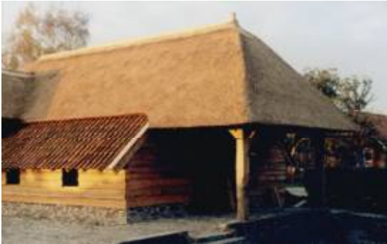
Wegzijde nieuwe schuur Scholendijk 4, Elsen
