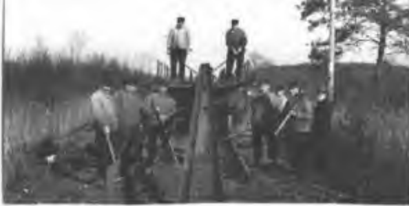
Na de opheffing van de spoorlijn Neede-Hellendoorn worden de materialen door een groep spoorwegarbeiders gedemonteerd en afgevoerd (foto genomen bij Diepenheim, 1935).
