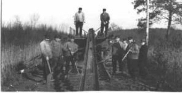
Na de opheffing van de spoorlijn Neede-Hellendoorn worden de materialen door een groep spoorwegarbeiders gedemonteerd en afgevoerd (foto genomen bij Diepenheim, 1935).
