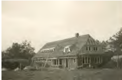
De bouw vordert gestaag
